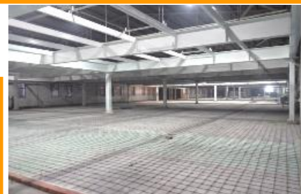
①KPL第一工場 クリーンルーム建設 2018年春竣工予定
