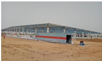
ラジャスタン州に建設中の新工場 (2019年量産開始予定)
