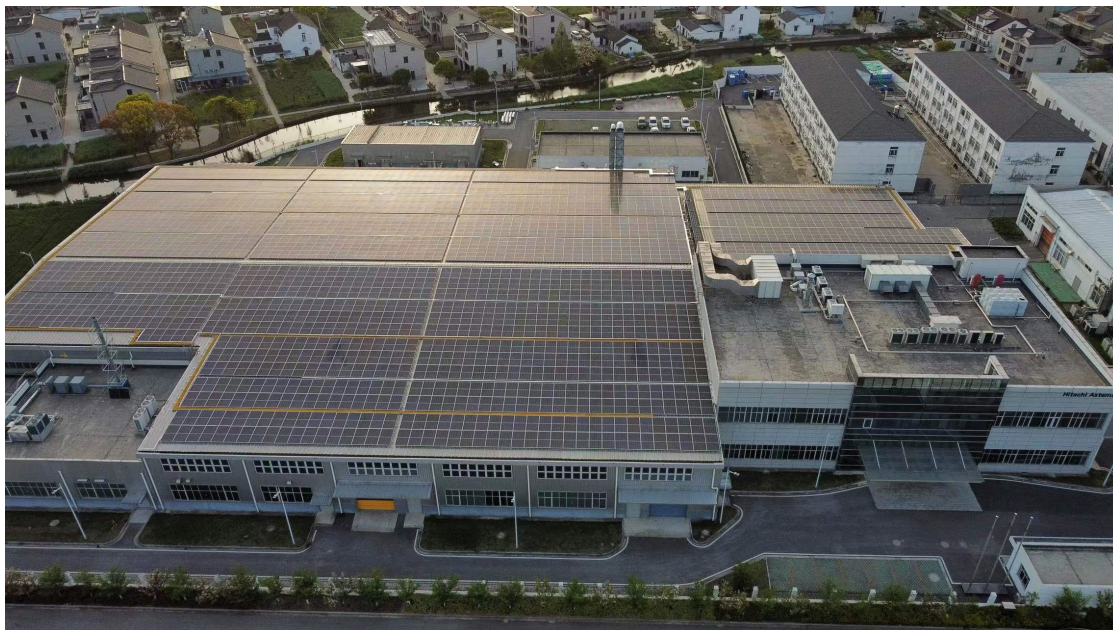
日立 Astemo 汽車系統(常熟)に設置された太陽光パネル
