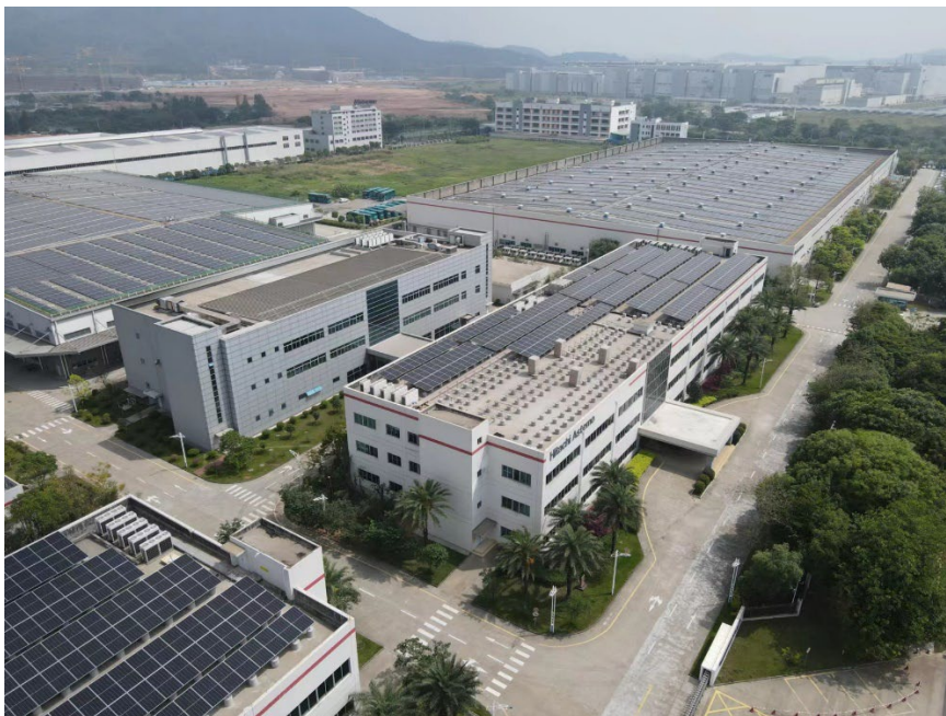
日立 Astemo 汽車系統(広州)に設置された太陽光パネル
